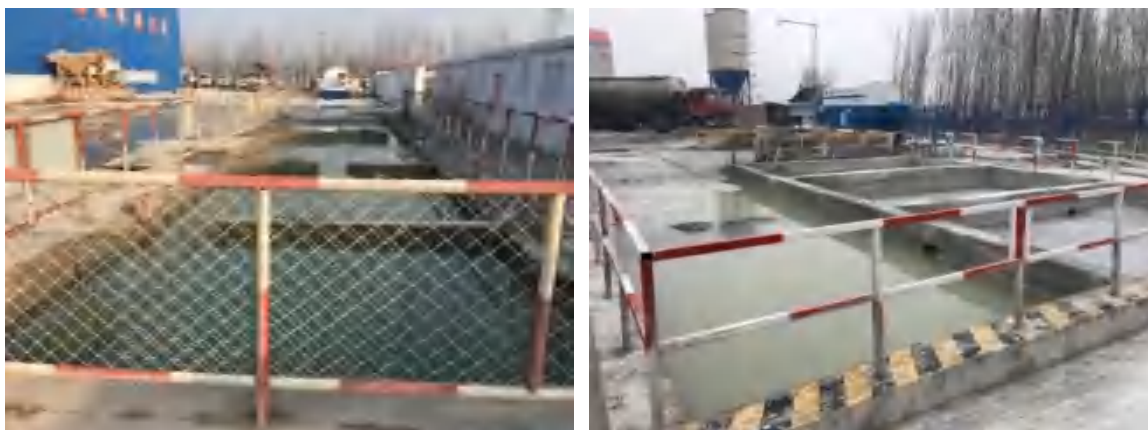
图 7.5-1 混凝土拌合站等施工场地沉淀池照片
