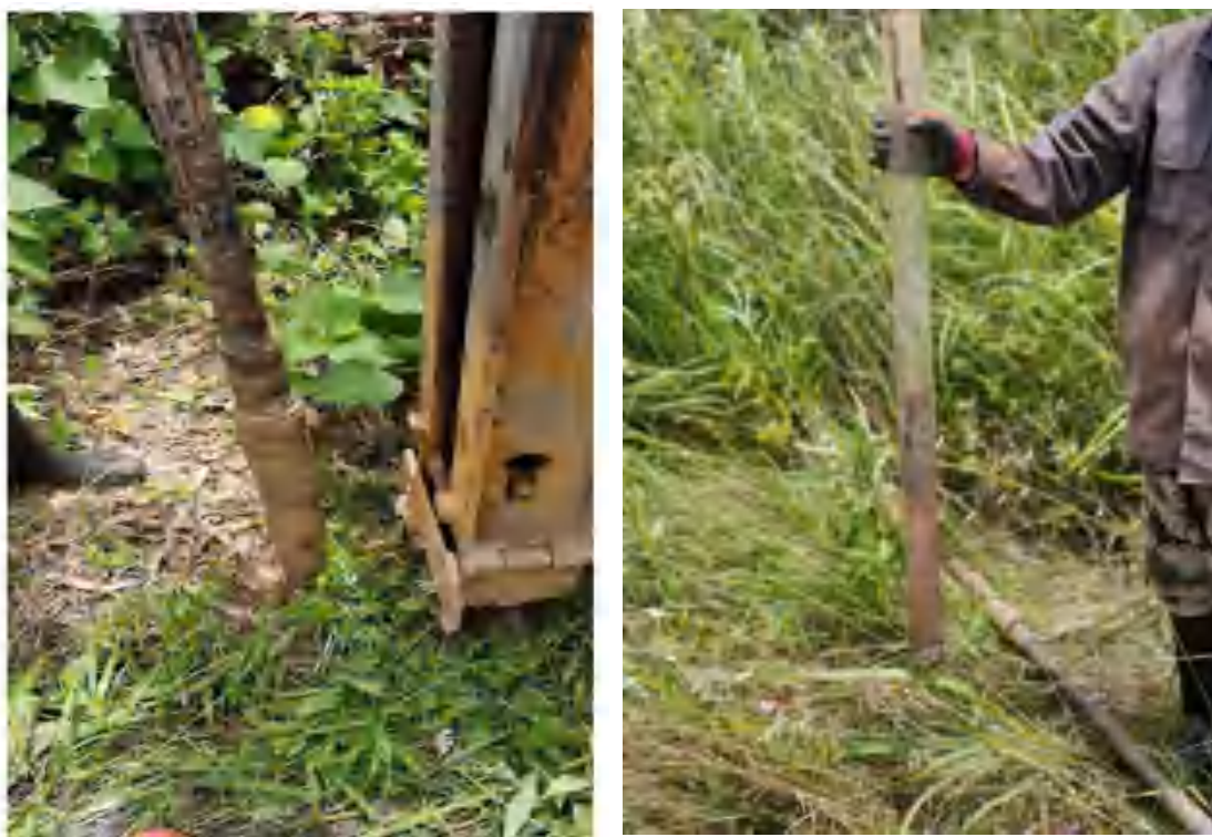
图 8.2-5 既有金华东机务折返段场地钻孔照片
