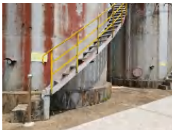
油罐地面硬化
